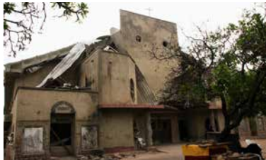
Eine nach einem durch Boko Haram verübten Anschlag zerstörte Kirche.
